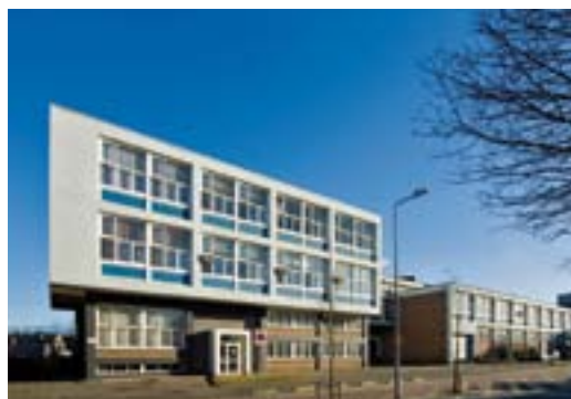
Melkfabriek, Hilversum (architecten: Breebaart, Martens & Kramer, 1956)
