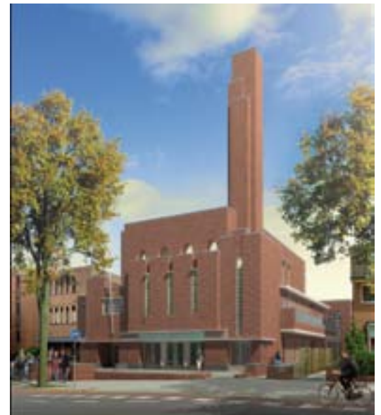
Ons Gebouw, Hilversum (architect: Jan van Laren, 1932)
