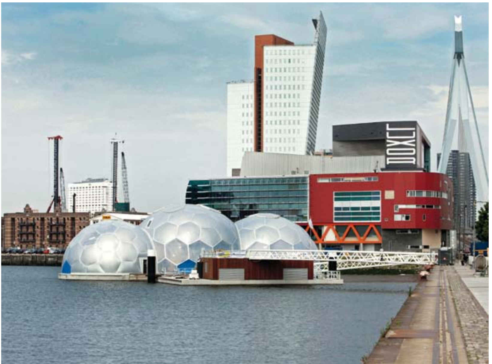
Drijvend Paviljoen, dat de komende vijf jaar dienst zal doen als tentoonstellingsruimte over de Rotterdamse klimaataanpak. Ontwerp: Deltasync/PublicDomain Architecten. Opdrachtgever: Gemeente Amsterdam
