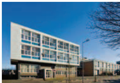
Melkfabriek, Hilversum (architecten: Breebaart, Martens & Kramer, 1956)
