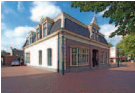
Fabrikeurswoning, Hilversum (architect: J. Rietbergen, 1888)
