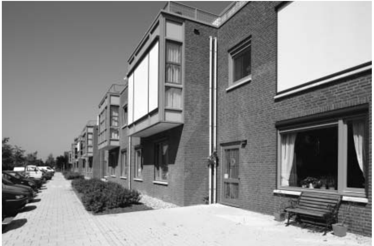
WOONZORGCENTRUM DE BOLDER, GROEPSWONINGEN AAN DE STRAAT
