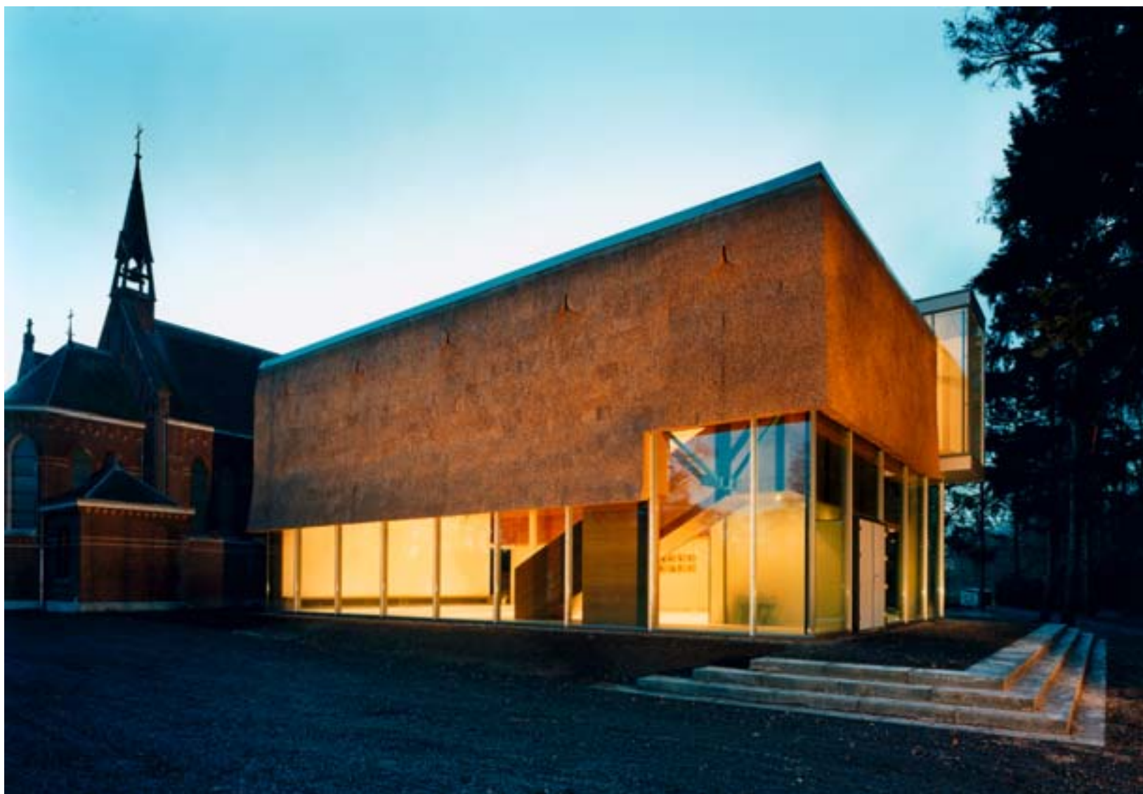
Aanbouw klooster Vught
