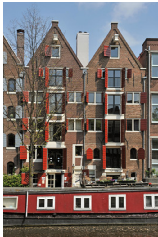
Voormalige pakhuizen Nijptang en Spitsbergen, Brouwersgracht, Amsterdam | FOTO STADSARCHIEF AMSTERDAM, MARTIN ALBERTS
