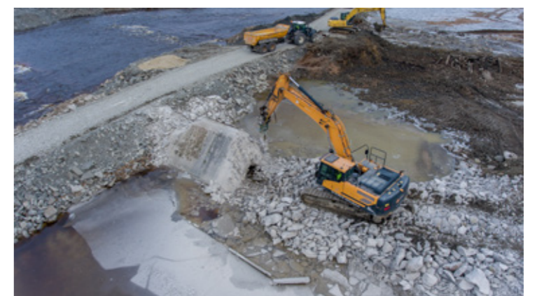
Damverwijdering in de Pärnu-rivier, Estland – één van de meest effectieve manieren van rivierherstel | FOTO MINISTRY OF ENVIRONMENT ESTONIA
