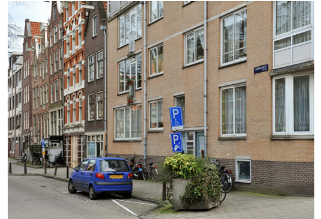
Sociale woningbouw, Lindengracht, Amsterdam
