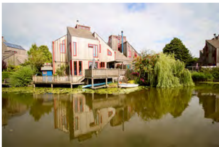
De Vier Vierkanten, houtskeletbouw in Alkmaar; ontwerp Abe Bonnema. FOTO'S: RUBEN FERWERDA
