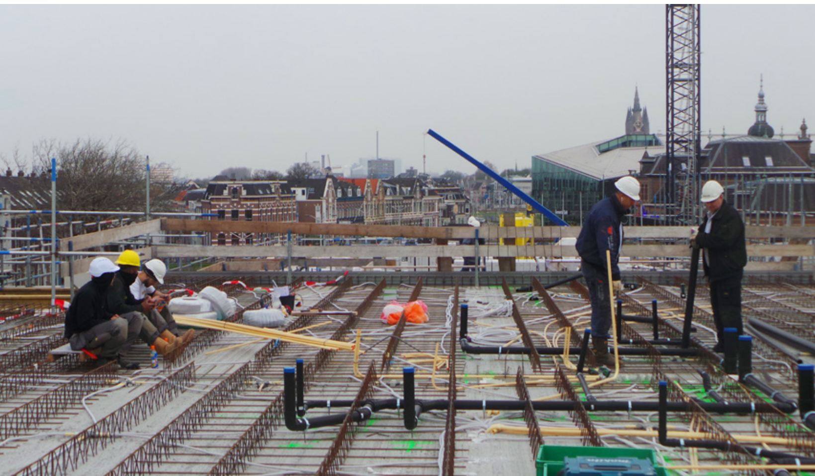
Tweede CPO-project in aanbouw
