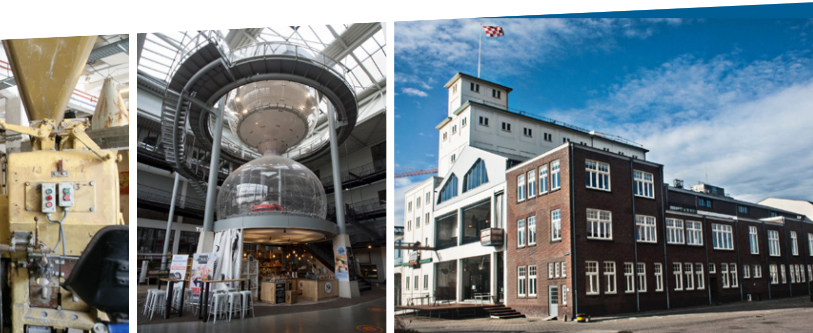
De oude industriële mengvoederfabriek in Veghel wordt stap voor stap omgevormd naar een cultuurfabriek | FOTO'S CHV NOORDKADE
