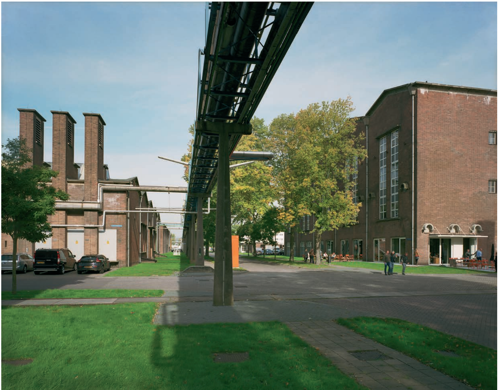
Industriepark Kleefse Waard Arnhem gebouw HB. Beeld Suzanne Valkenburg
