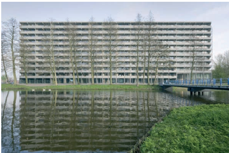
Kleiburg aanzicht gevel noord. Beeld Marcel van der Burg
