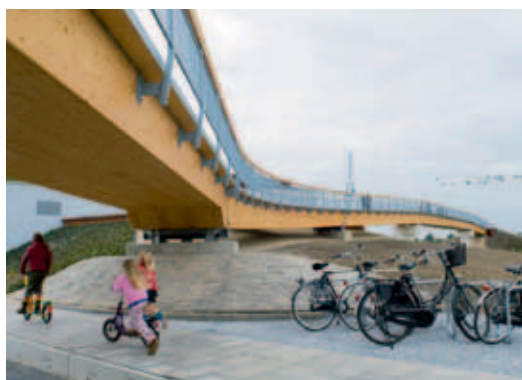
Fietsbrug over de Hollandse IJssel
