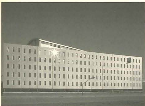
Koen van Velsen. Bibliotheek, 1988. Op 98 km van de wegwijzer te Eindhoven aan het Kerkplein te Zeewolde. De zwevende, geperforeerde gevel geeft licht in een ruimte die afzondering verlangt. Foto: Hildegard Diederik-Hick
