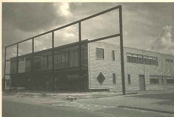
Tony Goossens. Machinefabriek Goossens bv, 1993. Op 3,5 km van de wegwijzer aan de Dillenburgstraat te Eindhoven. Een constructiestramien waar overheen een hal als een doos geplaatst is en waarvan het grid verder naar voren geschoven wordt om als billboard dienst te doen. Foto: Frank van der Linden
